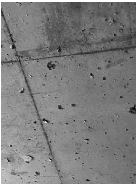
图7 楼板现场照片
